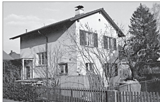
Haus vor dem Umbau
